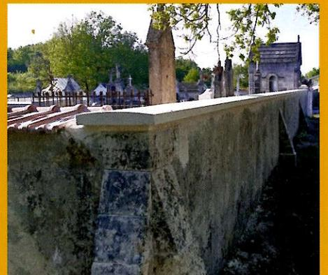
La façade a été refaite et les tuiles recyclées, ces dernières récupérées ont permis de combler les trous des tuiles manquantes sur la partie restante.
